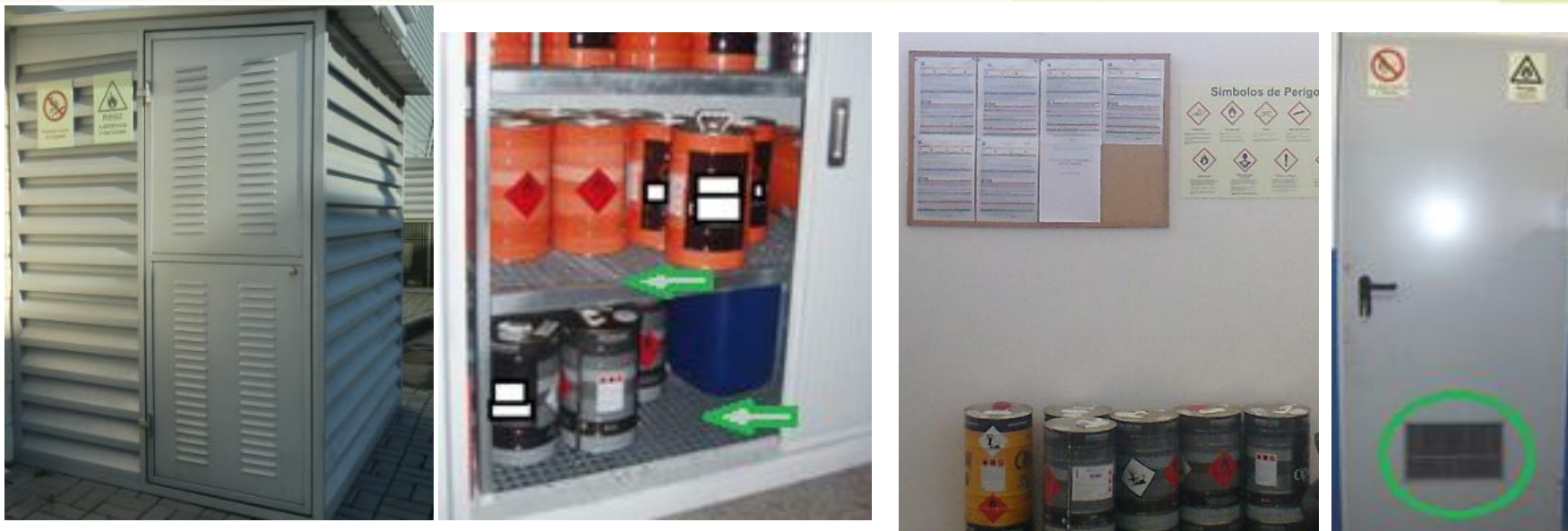
Armazenamento geral de produtos químicos
